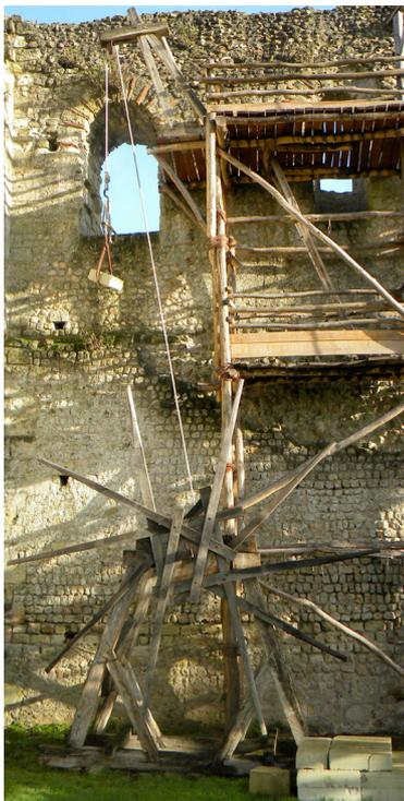
La chèvre (ci-dessous) est composée de pieds reliés en leur sommet par une poutre horizontale. Celle-ci porte une poulie dans laquelle passe une corde (au sommet de l'échafaudage) ; celle-ci est entraînée grâce à une roue (en contrebas de l'échafaudage) qui permet de démultiplier la force. Plus la roue est grande, moins l'ouvrier a à faire d'effort pour l'actionner.
